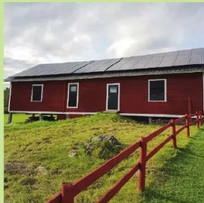
Jon-Erik Jonssons ladutak är täckt med solcellspaneler.
