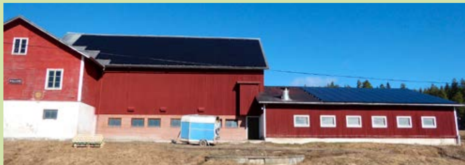
Solceller har monterats på tre tak på ekonomibyggnader, fotot visar panelerna på två av taken.
