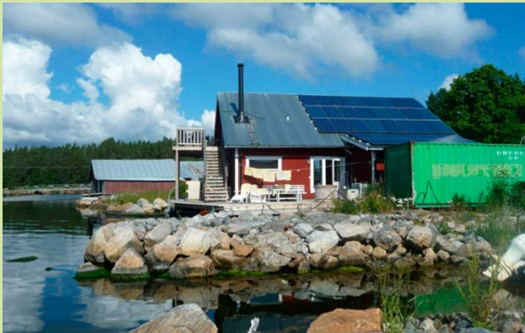
På den efter branden nyuppförda sjöboden har Borkbo Salteri installerat cirka 70 m 2 solceller.
