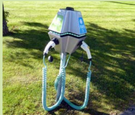
Just nu den enda publika laddstolpen i Ljusdal, finns utanför Ljusdal Energis fastighet på Pårgsgatan. Kapaciteten är 3,7 kW /230 V /16 A, laddtid ungefär 8 timmar för urladdat batteri.
