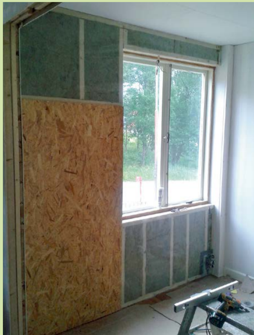
Invändig tilläggsisolering av vägg kan halvera energiförlusten genom väggen men är förknippat med fukttekniska risker.
