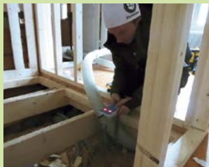
Staffan sprutar in isolering i bjälklaget. Med trådlös kommunikation kan han starta och stoppa fläktaggregatet, och reglera luftmängd och packningsgrad.
