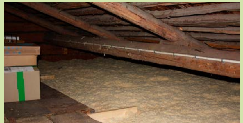
Tilläggsisolering av vind.
