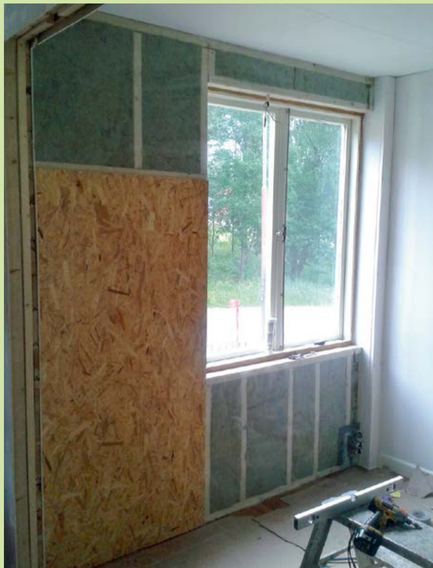
Invändig tilläggsisolering av vägg kan halvera energiförlusten genom väggen men är förknippat med fukttekniska risker.
