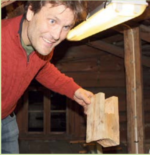
Petter Landin håller upp ett "torn" som han använt som avstånd mellan gammal och ny regel. Fördelen blir att endast tornet och inte hela regeln utgör köldbrygga.
